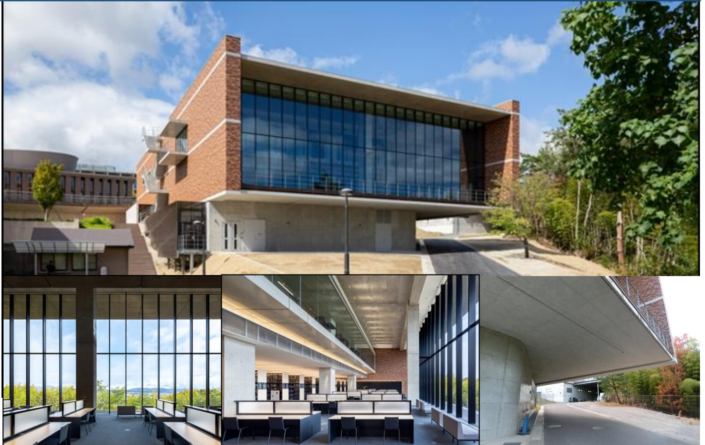
現場打ち PC 工法：京都大学（桂）図書館
